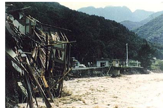
昭和57年洪水被害状況
