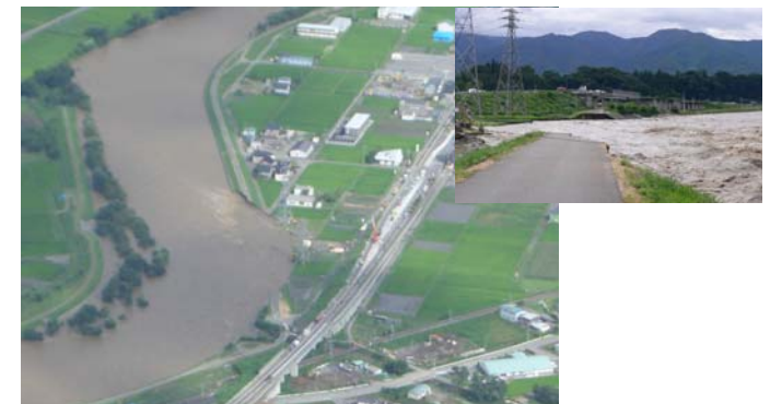
平成18年洪水時の十沢橋右岸上流決壊の様子
