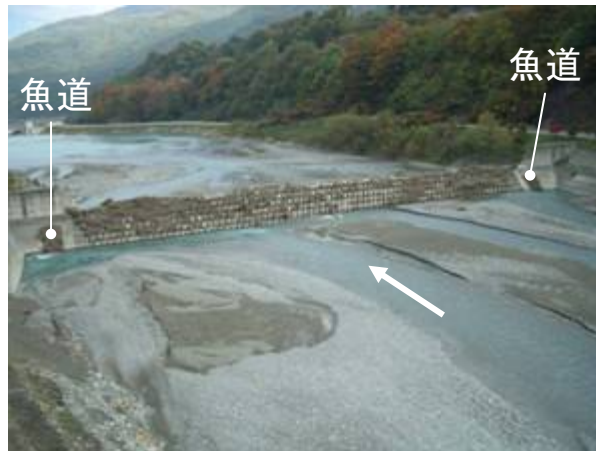
H19.9洪水後 洪水後、貯砂容量に余裕を残しており、完全には機能を発揮していない
