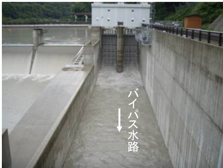
主ゲート・バイパス水路(H20/6/23 16:40)
