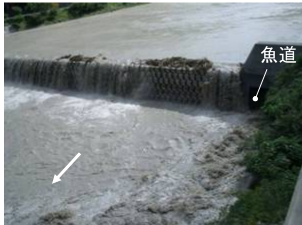
H19.9洪水時 貯砂ダムの水通しだけでなく魚道からも土砂が流下している
