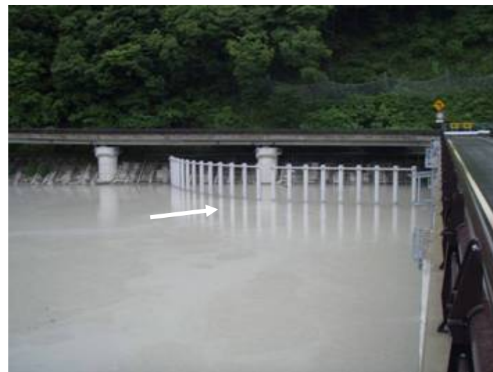
流木止(流木の進入防止)(H20/6/23 16:40)
