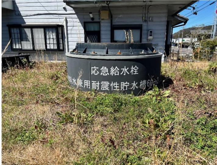
災害時に避難所となる防災コミュニティセンターには耐震性貯水槽を設置し、避難時の飲料水が確保できるようにしている
