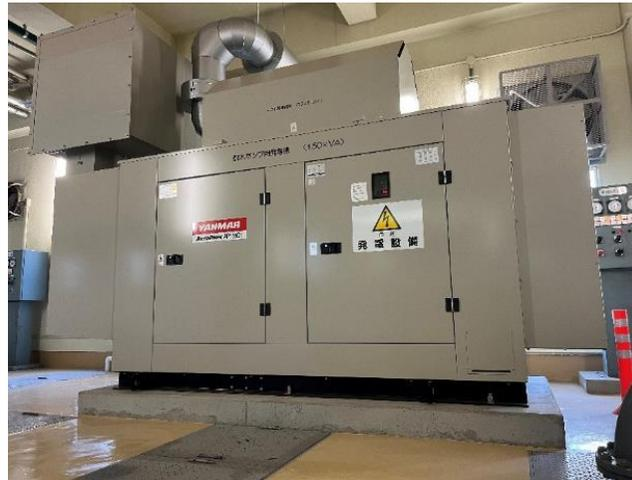
④配水ポンプ用発電機の設置: 落雷などによる瞬時停電時に配水ポンプが停止する恐れがある場合、一時的な断水や水圧低下を回避
