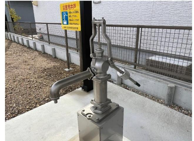
⑤災害用井戸の設置: 災害時に手押しポンプにより断水時の水源として利用
