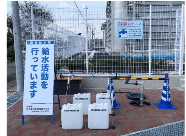
③ 災害時給水ステーションの設置: 耐震管路に設置した応急給水栓により、断水時の拠点給水を確保
