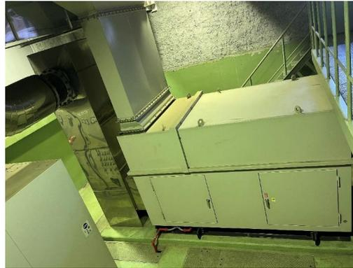
① 自家用発電機の設置: 停電時の動力源である自家用発電機を保有することで配水施設の稼働を可能
