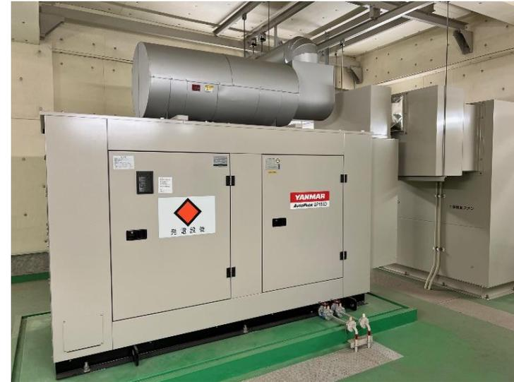
規模の大きなポンプ場には非常用発電装置を整備し、災害時にも運転ができるようにしている
