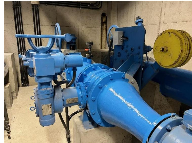
規模の大きな配水池には緊急遮断弁を整備し、災害時に水を確保できるようにしている
