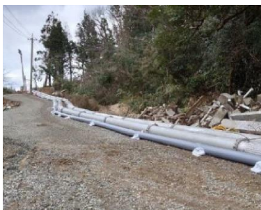
写真-2 仮設配管状況
