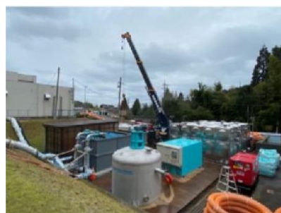
写真-3 可搬型浄水装置設置
