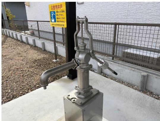
写真-13 防災用井戸（丹羽広域事務組合）
