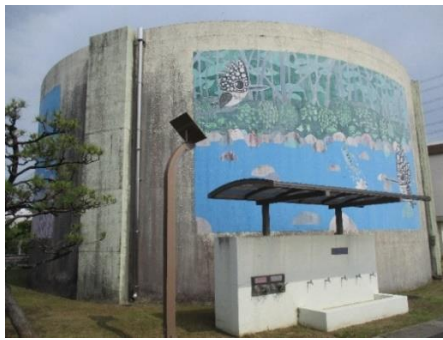
写真-9 常設緊急給水栓（北方町）
