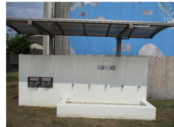
応急給水栓の写真
