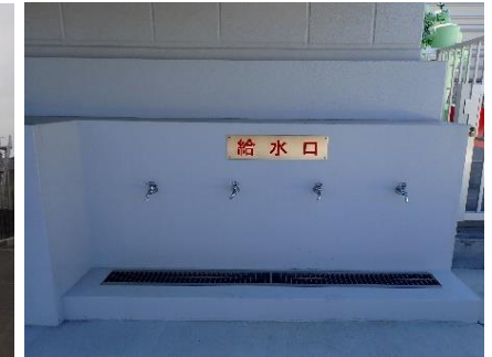
【写真-1】緊急給水設備（西水源地）
