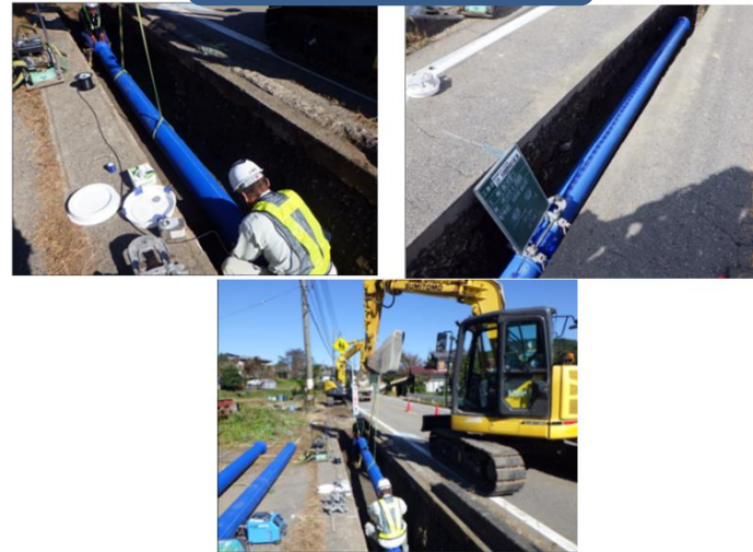
耐震管布設状況
