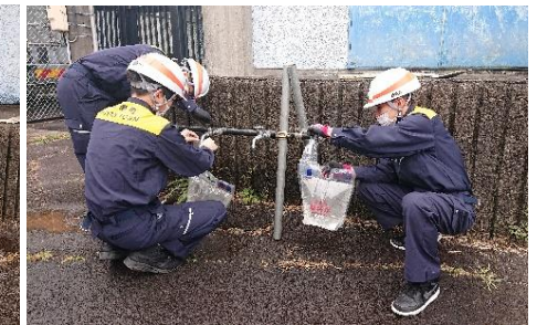
【写真-2】防災訓練時の応急給水栓
