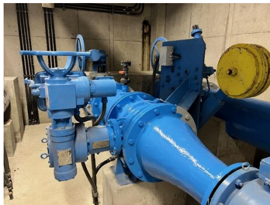
写真- 1 4 緊急遮断弁（御嵩町）
