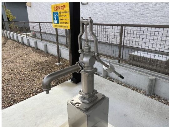
写真- 1 0 防災用井戸（丹羽広域事務組合）
