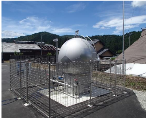
写真-1 耐震性貯水槽（豊田市）
