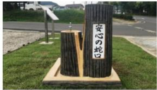
写真-7 応急給水拠点（長野県）
