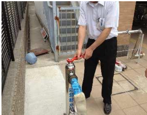
応急給水栓操作状況
