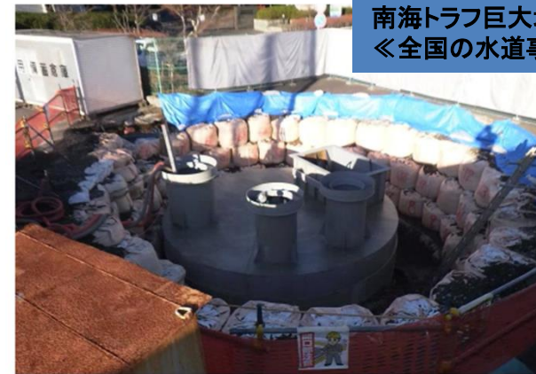
〔静岡市の事例（縦型）※工事中〕
