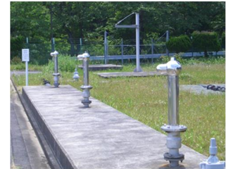
【浄水池・調整池の応急給水設備】
