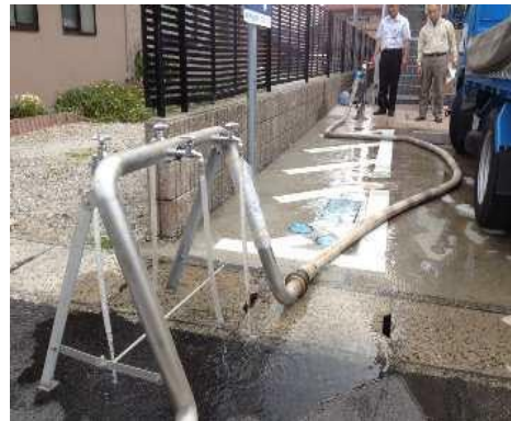
応急給水栓操作状況
