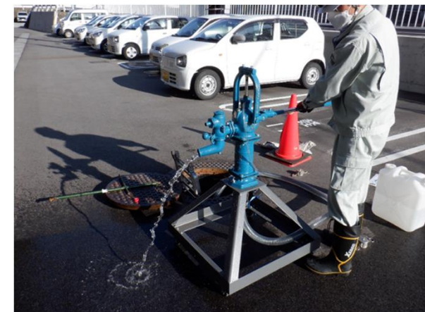
耐震性貯水槽から手押しポンプへ
