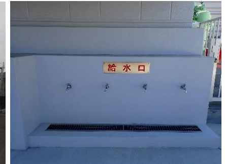
【写真-1】緊急給水設備（西水源地）
