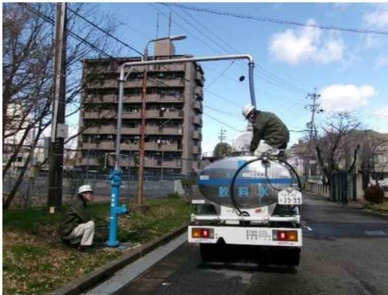
【写真-1 屋外給水用配管】
