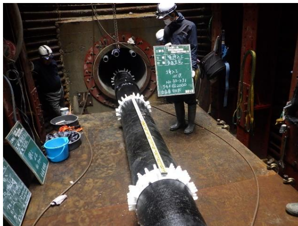
耐震管布設状況
