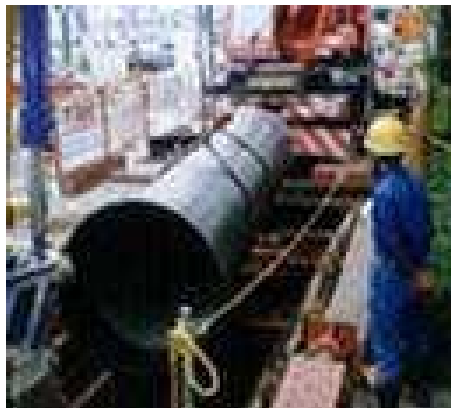
配水幹線の耐震化
