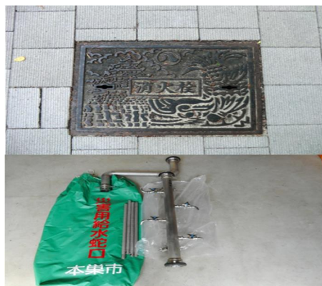
写真- 3 仮設給水栓（本巣市）
