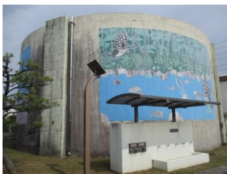
写真- 6 常設緊急給水栓（北方町）
