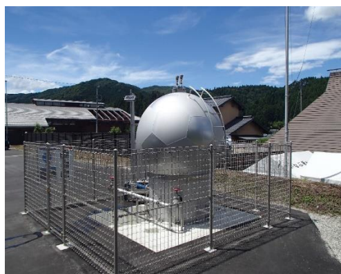
写真- 1 耐震性貯水槽（豊田市）
