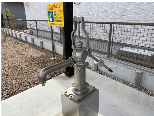
写真- 1 0 防災用井戸（丹羽広域事務組合）
