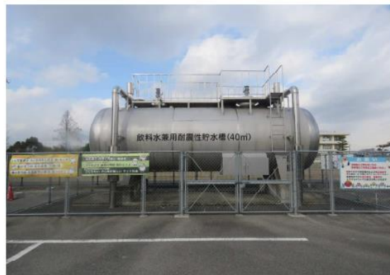
写真- 2 耐震性貯水槽（輪之内町）
