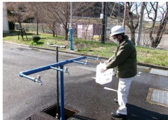
写真- 4 仮設給水栓（岐阜市）
