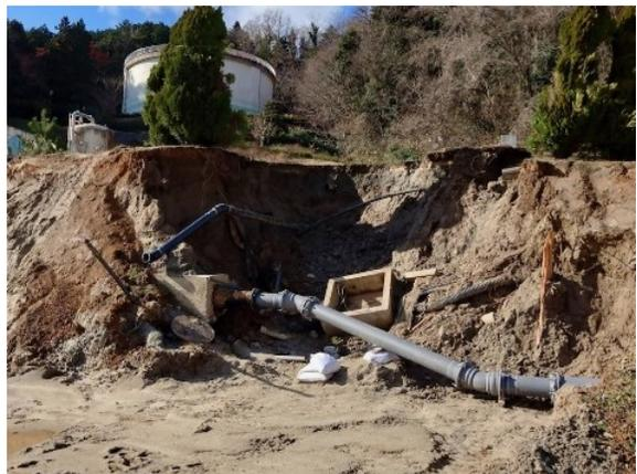
浄水場内の配管損傷（七尾市）
