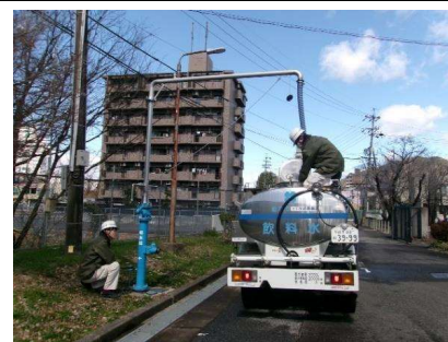
【写真-1 屋外給水用配管】
