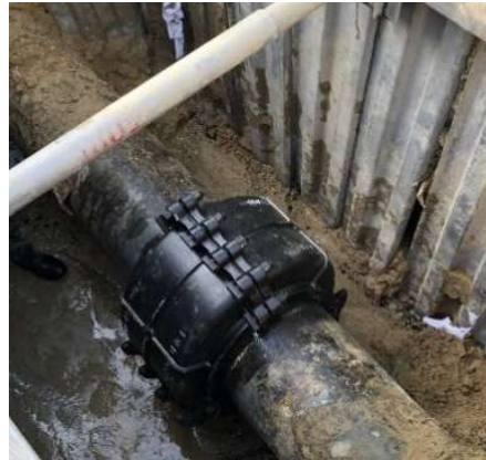
送水管の漏水修理
