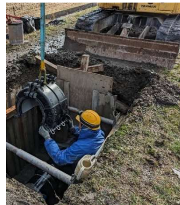
送水管の漏水修理
