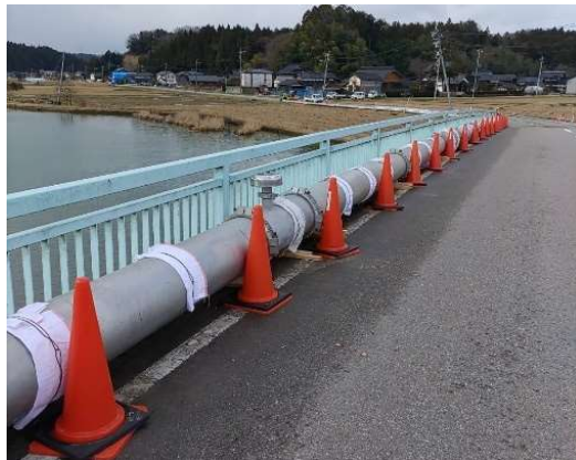
送水管の仮設管
