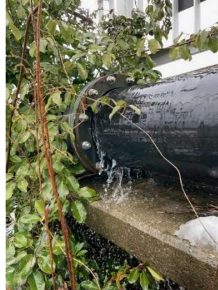
水管橋漏水
