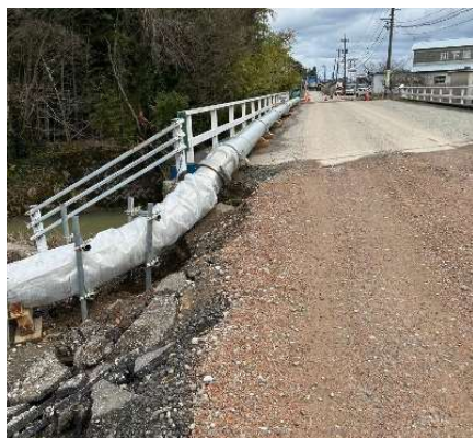
水管橋の仮設管
