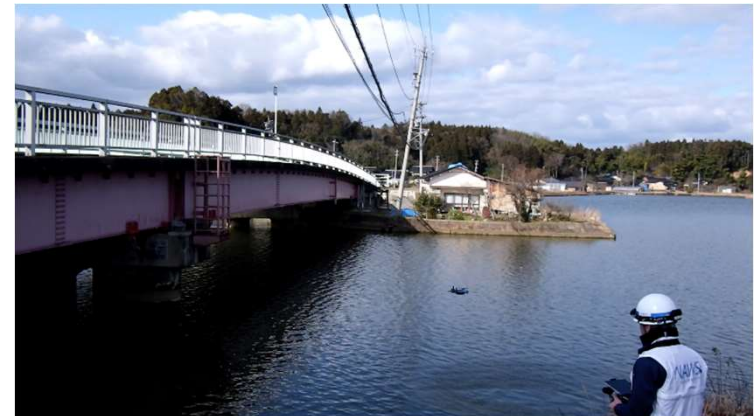
水管橋のドローンによる調査
