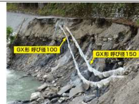
耐震継手管被災状況（被害無し）
