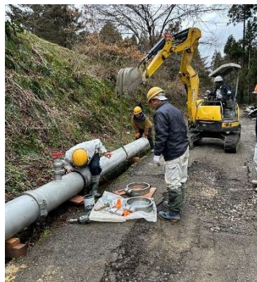
送水管の仮設管
