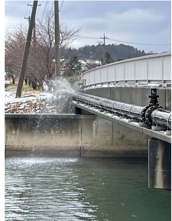
水管橋漏水
