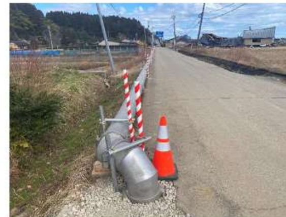
珠洲市 送水管復旧
