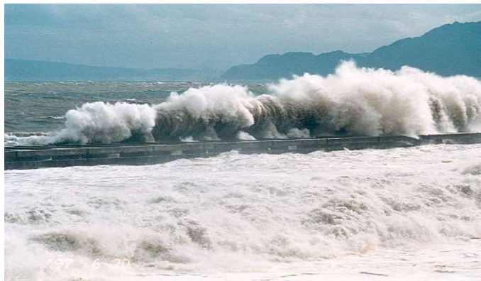
有脚式離岸堤による消波
