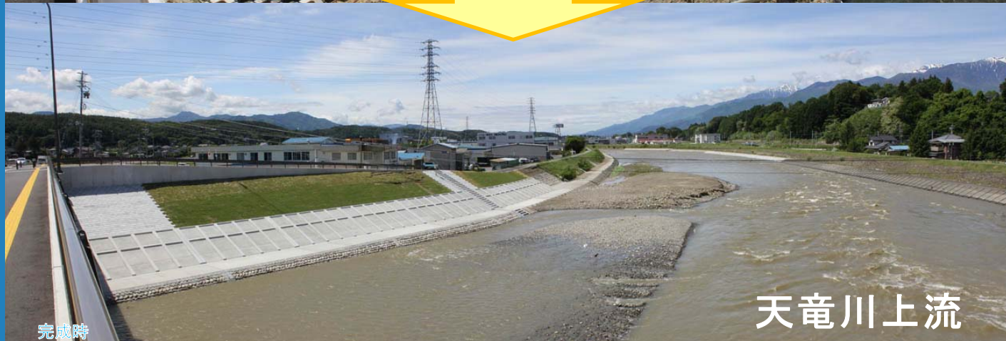
侵食対策工事中
