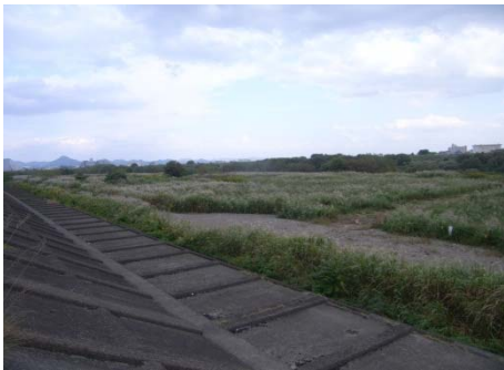
掘削前の状況
