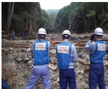
TEC-FORCE隊による被災状況調査
