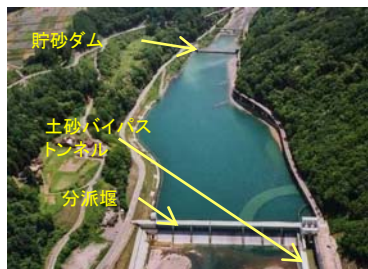
土砂バイパス施設 (H17完成)
