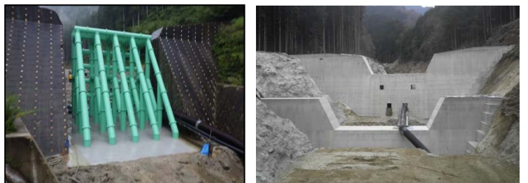
■ 第1堰堤の鋼製スリット設置完了 (H27.6月末)
