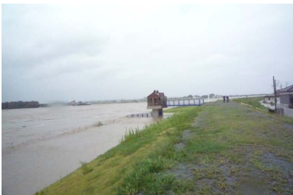
堤防整備箇所の出水状況
