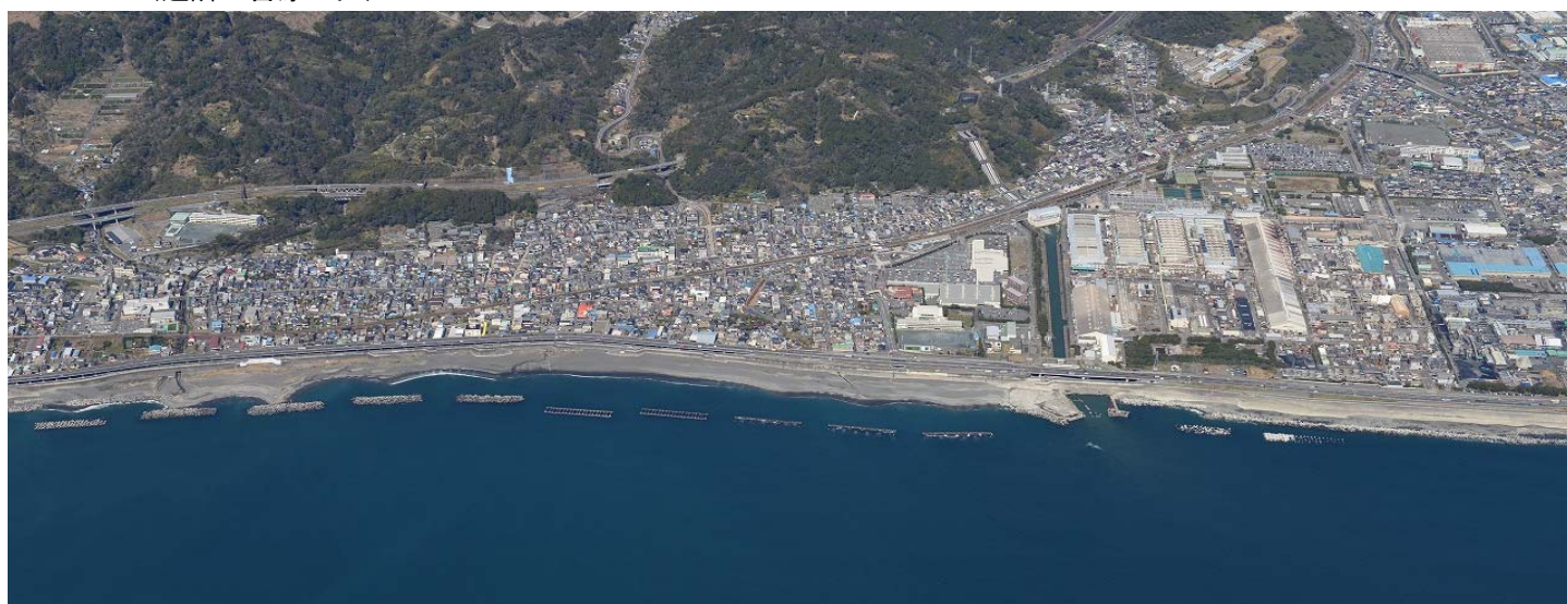
離岸堤の施工状況
