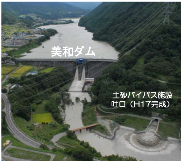
土砂バイパス吐口からの土砂排出状況
