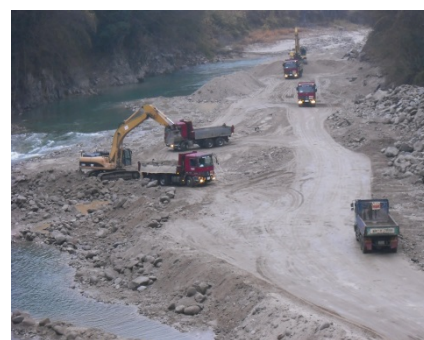
堆積土砂の撤去
