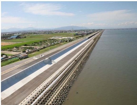
完成した高潮堤防 (三重県桑名市)
