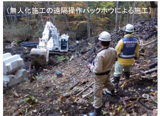
コンクリートブロック積み砂防堰堤
