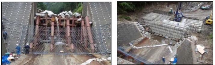
■ ネット捕捉工設置状況
