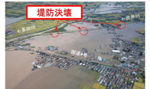
平成27年9月関東・東北豪雨における災害復旧工事 (宮城県大崎市)
