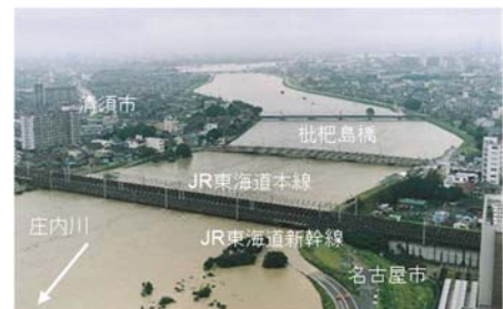
平成12年9月(東海豪雨)の出水状況
