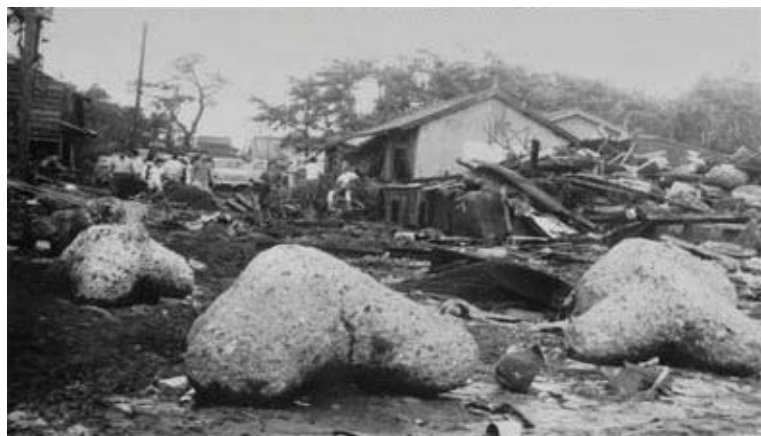
昭和41年台風26号による被災状況 (近隣の吉原工区)
