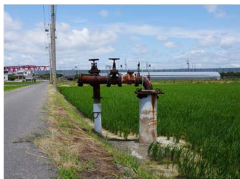
三重県桑名郡木曾岬町の井戸の抜け上がり状況 (平成26年6月撮影) ※ 近傍の水準点における累積沈下量：117cm (昭和36年～平成27年)
