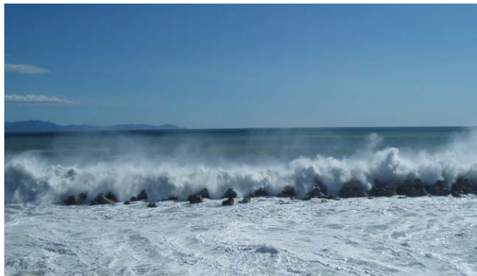
ブロック式離岸堤による消波
