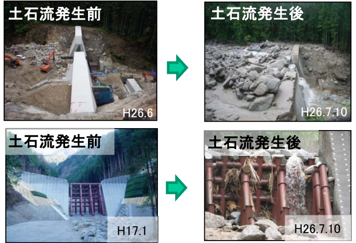
＜既設砂防堰堤による捕捉状況＞
