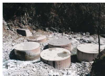
与田切セル群堰堤 （長野県飯島町）
