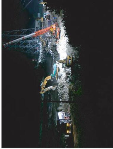
⑤7/23 1時 緊急復旧工事の根固ブロック投入状況
