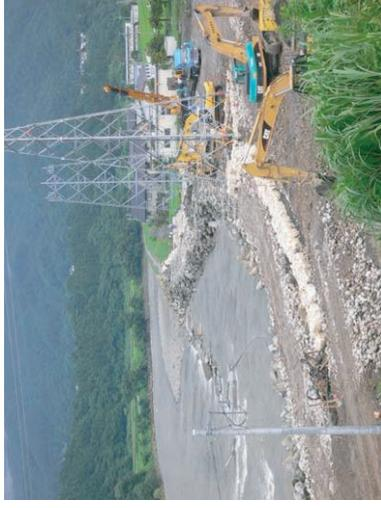
⑥7/24 15時 緊急復旧工事の根固ブロック投入完了
