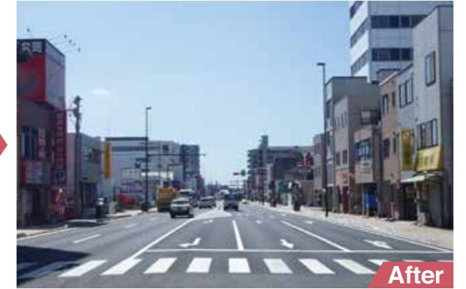
静岡県静岡市駿河区石田一丁目(市)静岡下島線
