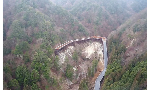
⑤二日洞工事用道路
