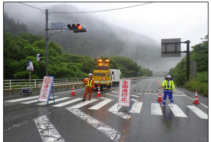
R6.6.28 通行止めの様子(田立入口交差点)
