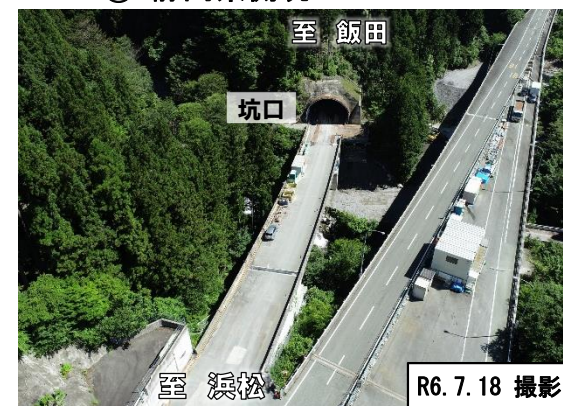
② 静岡県側坑口
