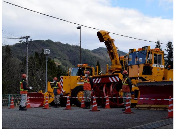
除雪機械の「安全点検」
