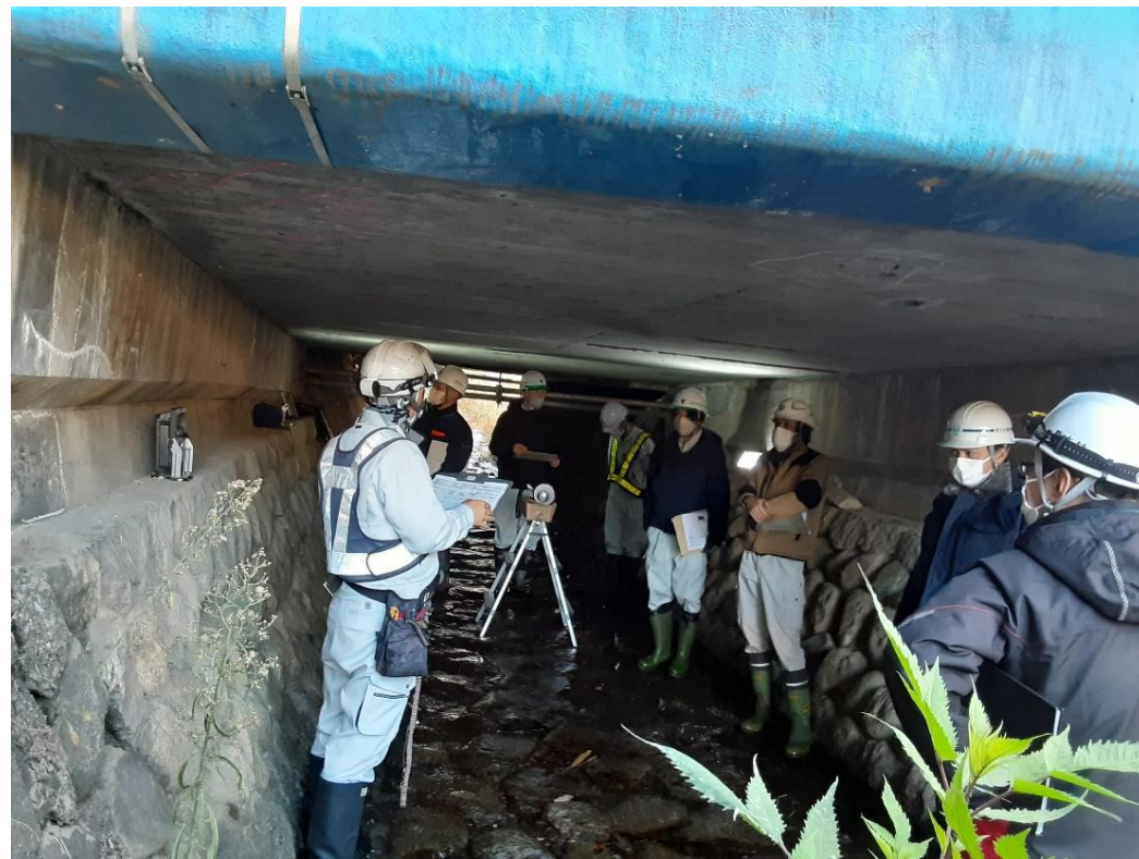
国道153号 観音沢橋
