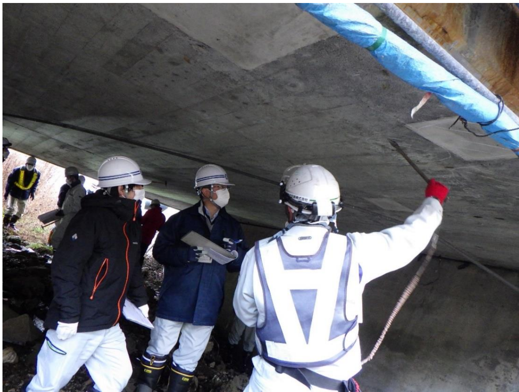
国道19号 母沢橋
