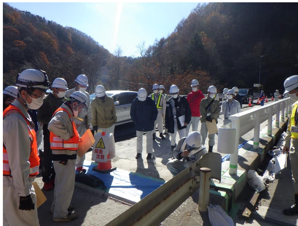
現場にて補修内容の具体的な説明をしました。
