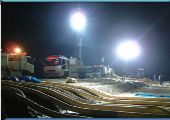
照明車と排水ポンプ車による排水作業
