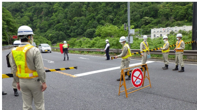
遮断機は車道の両側についており、ゲートを下ろし通行規制訓練（一時通行止め）を行います。
