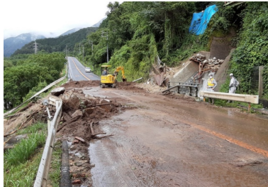
応急復旧作業
