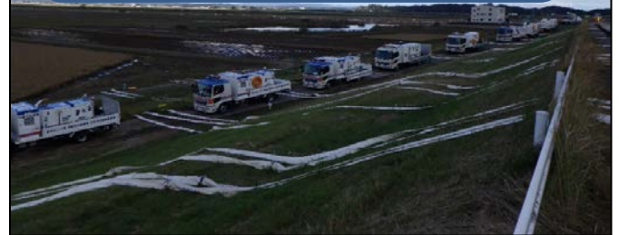
宮城県大崎市の浸水箇所での排水作業 (全国から集まった排水ポンプ車・照明車 R1.10/16~23)
