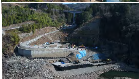
転流工吐口部施工状況
