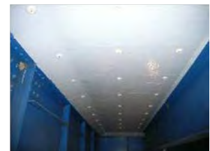
【対策事例】床版コンクリートひび割れ
