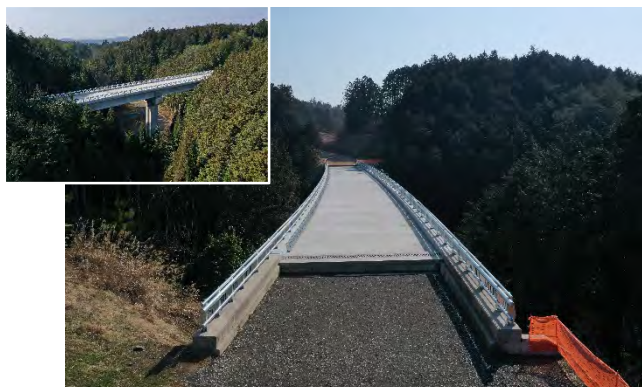
付替道路418号(潮見地区)6号橋
