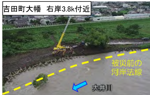
令和2年7月 前線による河岸浸食状況
