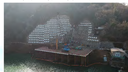
転流工呑口部施工状況
