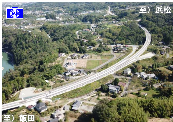
ちよ 千代インターチェンジ (R2.10撮影)
