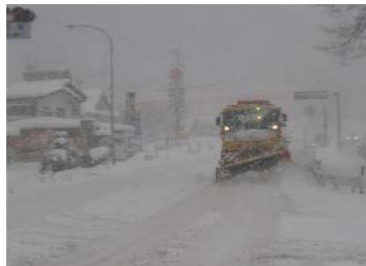
除雪トラックによる除雪作業
