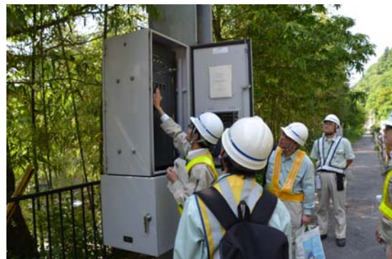
遮断機操作の様子
