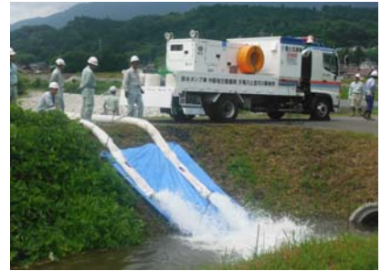
ポンプ排水状況
