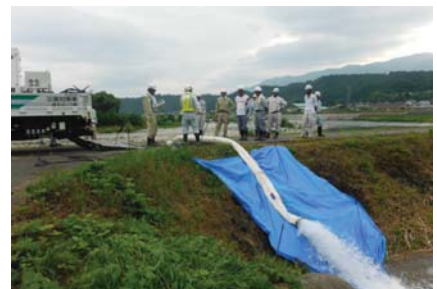
ポンプ排水状況
