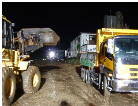
土砂撤去作業
