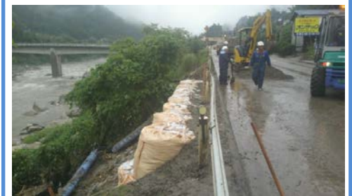
応急復旧完了
