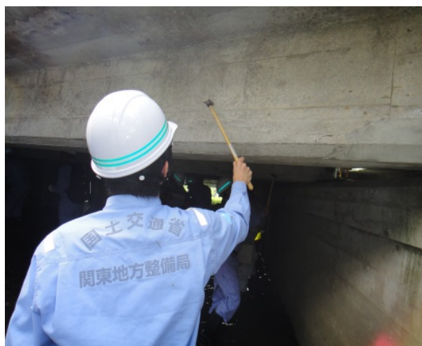
橋梁点検状況
