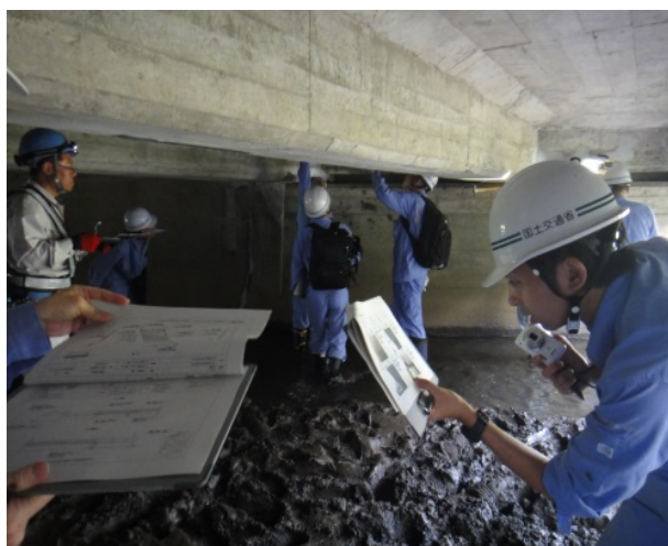
橋梁点検状況
