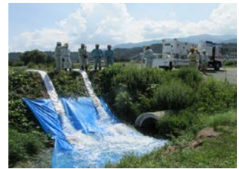
ポンプ排水状況
