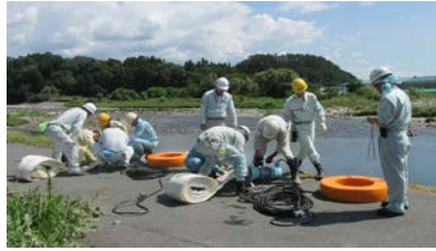
排水ポンプ等の降ろし
