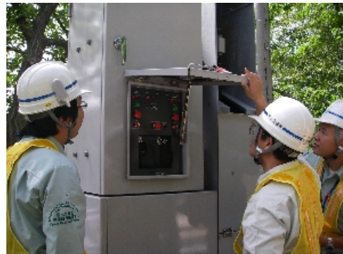
遮断機操作の様子
