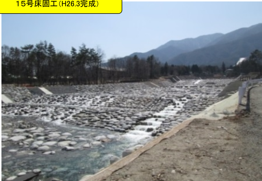
15号床固工(H26.3完成)
