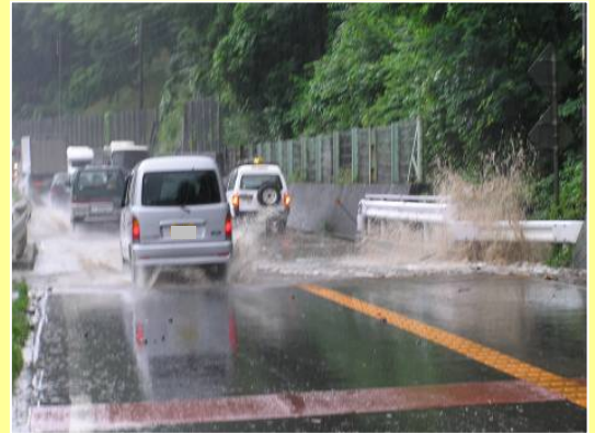
時間128mmの大雨により道路が冠水。国道19号が約3時間片側交互通行規制となった。 (H18.7.17)
