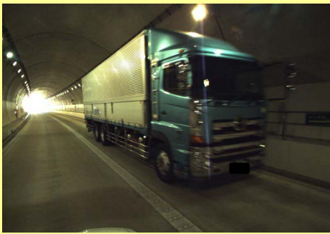
棧改良 かけはしトンネル内の状況
