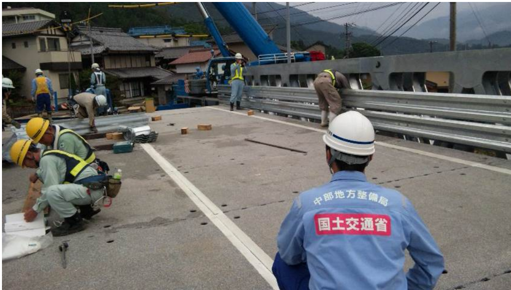
⑦ガードレール取付状況(7月14日 16:30撮影)
