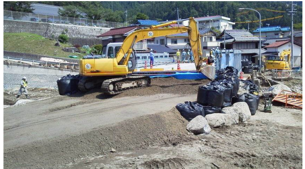
⑧仮橋取付部施工状況(7月15日 14:00撮影)
