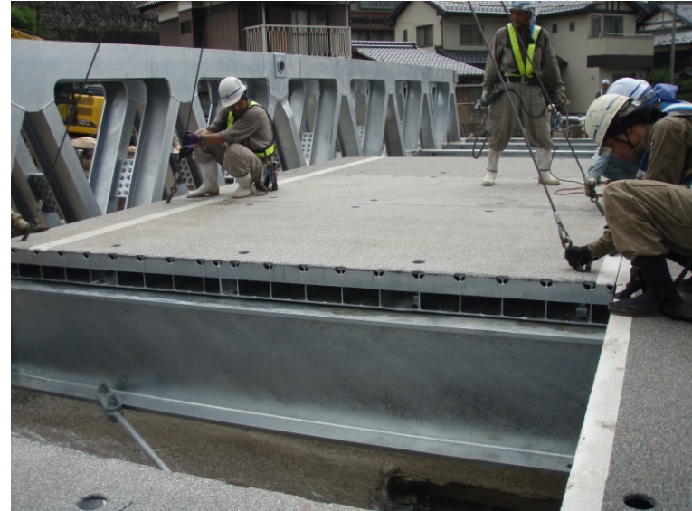
⑥横桁・横構取付、覆工板据付状況(7月14日 15:00撮影)
