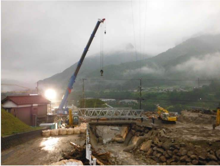
⑤トラス桁架設状況(7月13日 18:00撮影)
