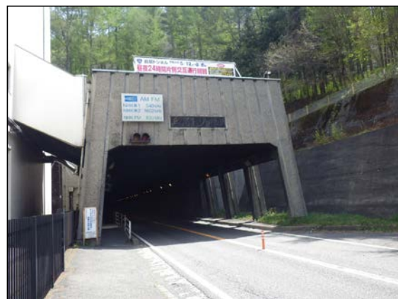
トンネル坑口(藪原)
