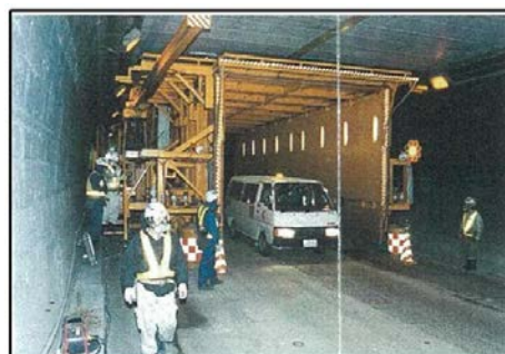
天井板撤去時のイメージ写真
