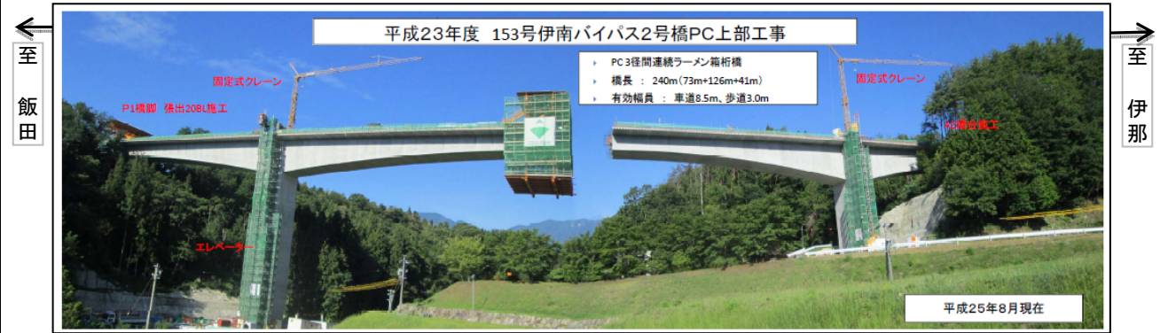
2号橋PC上部工事
