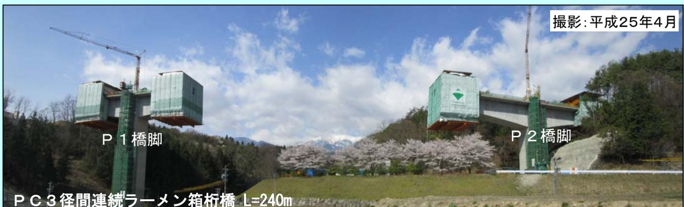
地上から橋梁上面までの高さは、P1橋脚で約45m、P2橋脚で約26m
