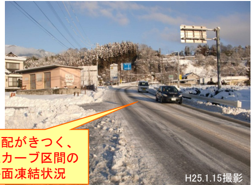
■ 現道153号の状況写真 <写真①：急カーブ区間>
