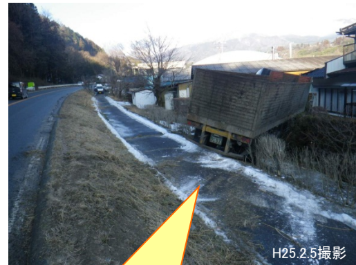
<写真②：路面凍結による事故状況>
