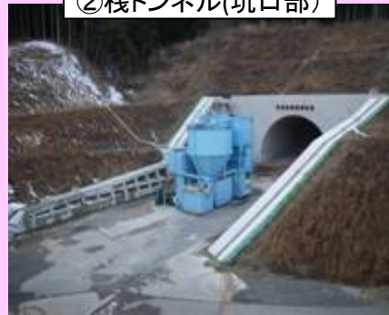
かけはし ②棧トンネル(坑口部)
