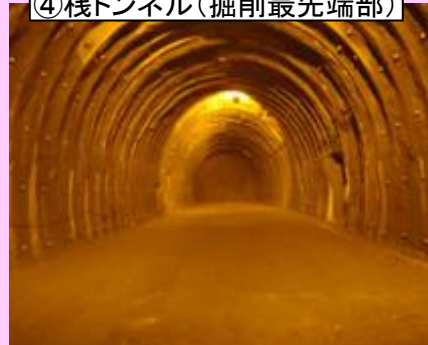
かけはし ④棧トンネル(掘削最先端部)
