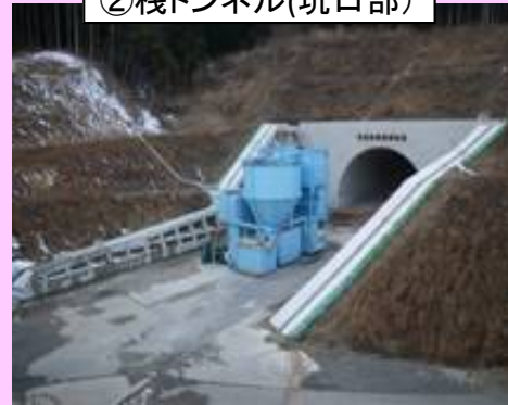
②棧トンネル(坑口部)
