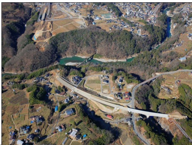
三遠南信自動車道 飯橋道路
