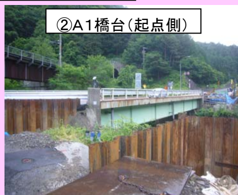
■A1土留め鋼矢板を施工
