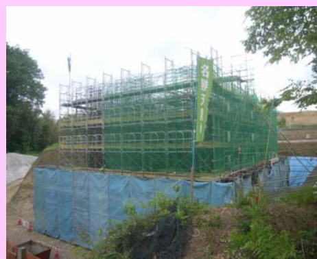
てんりゆうきやう ②天龍峡大橋(仮称)下部工
