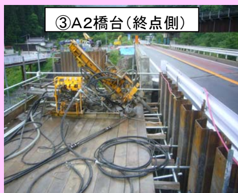
■A2土留めアンカー打設を施工
