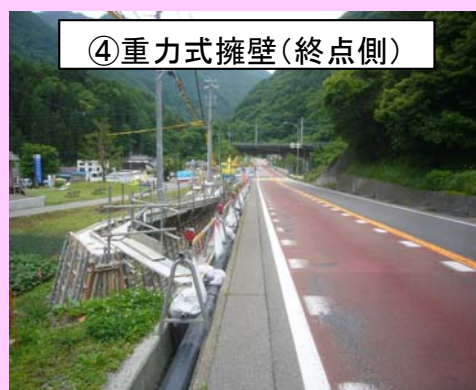
■重力式擁壁を施工
