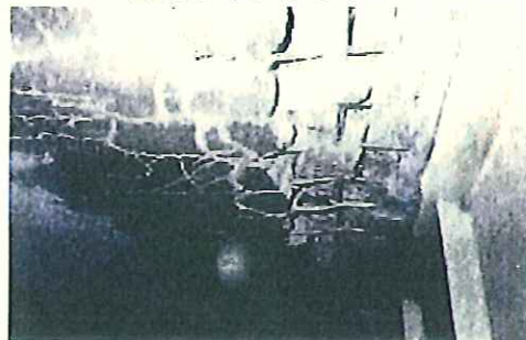
橋桁の亀裂
