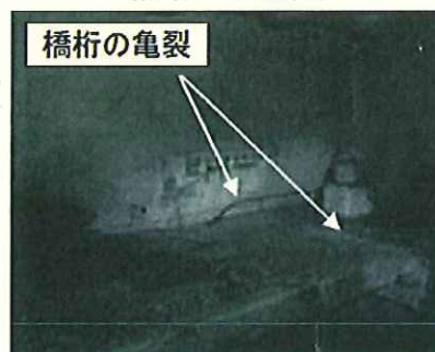
橋桁の亀裂
