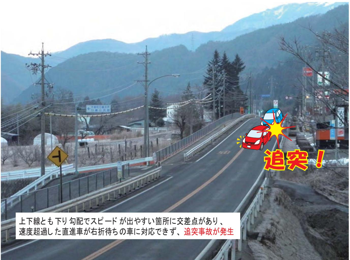
上下線とも下り勾配でスピードが出やすい箇所に交差点があり、速度超過した直進車が右折待ちの車に対応できず、**追突事故が発生**
