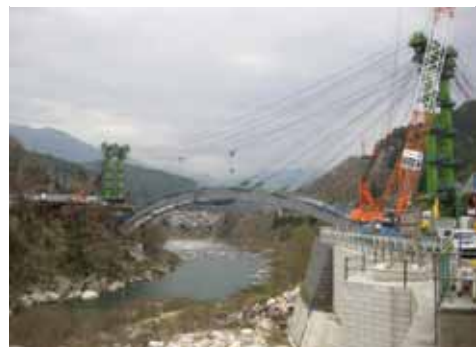
木曽川上流側からの状況
