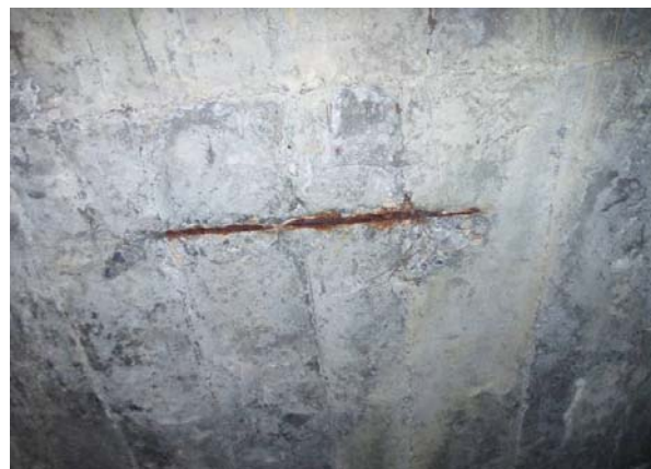
床版コンクリートの剥落
