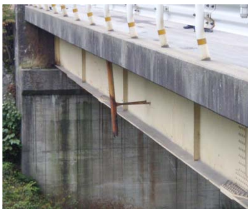
排水管の劣化
