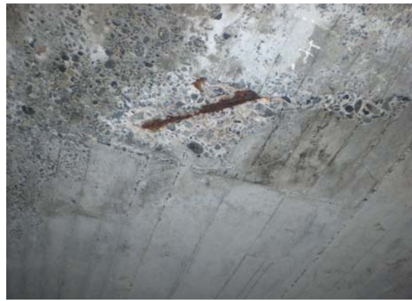
床版コンクリートの剥落
