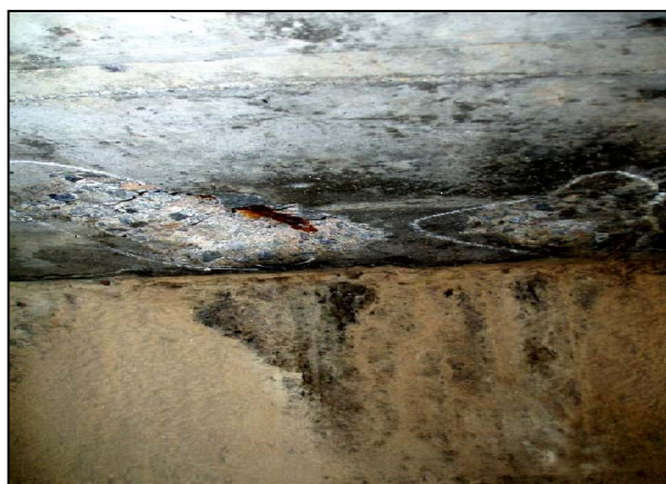
床版コンクリートの剥落
