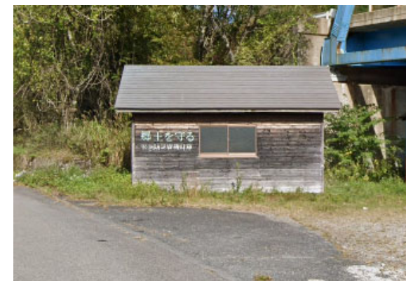
災害対策用資材の備蓄・点検
