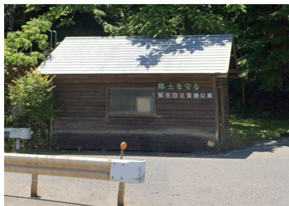
災害対策用資材の備蓄・点検
