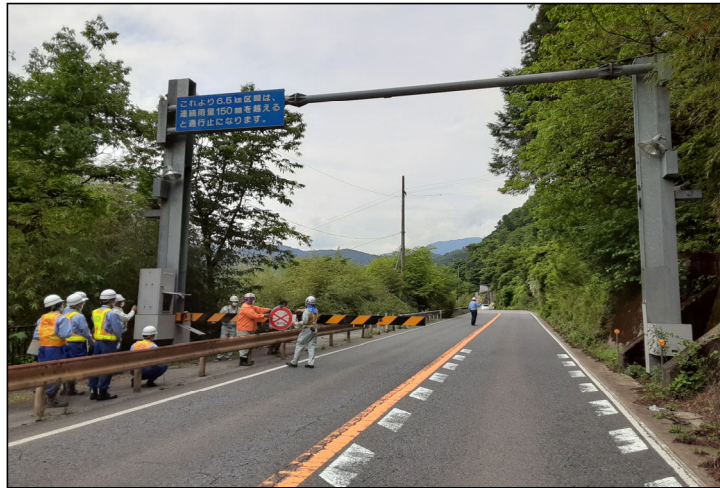
遮断機は車道の両側についており、ゲートを下ろし通行規制訓練（一時通行止め）を行います。
